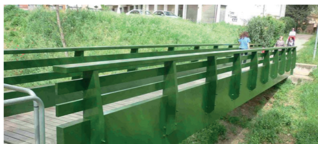
Substitució del paviment de la passera del final del carrer de Federico Garcia Lorca (Torres de Tialà)
