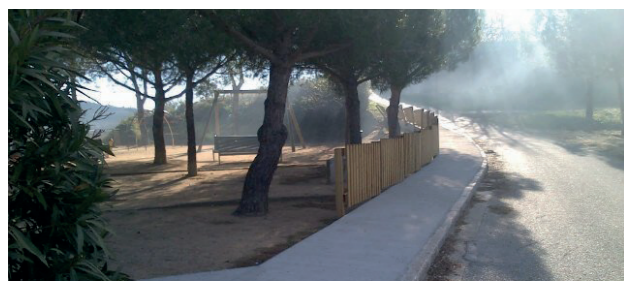
Tancament i arranjament de la vorera del mirador (Torre Gironella)
