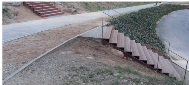
Adequació del vial que connecta l'aparcament situat al final del carrer del Pont de la Barca amb l'av. de França (Fontajau)
