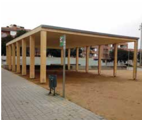
Instal·lació d'un cobert a la plaça de Miquel de Palol
