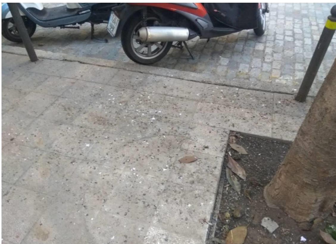
Dormidor nº6. c/Grober. Afectació de defecacions.
