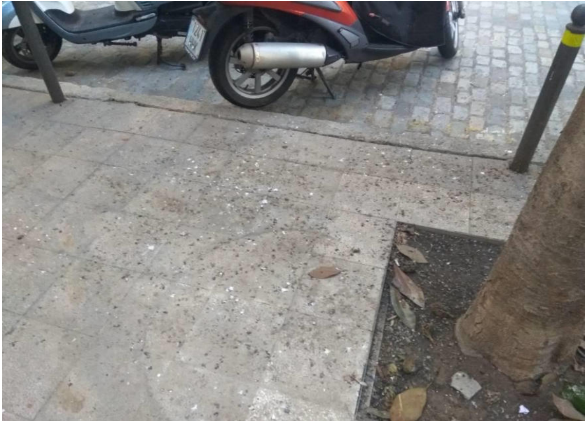
Dormidor nº6. c/Grober. Afectació de defecacions.
