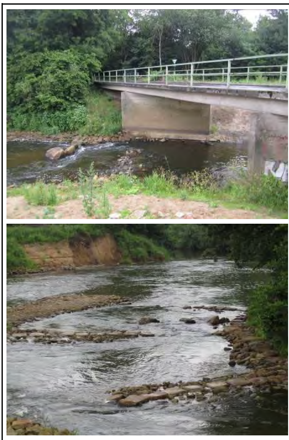
Figura 16.- Exemple de transformació d'una barrera (base de pont) en una rampa de fons per a peixos: Münster, Alemanya. Fotos: Quim Pou – Sorelló.
