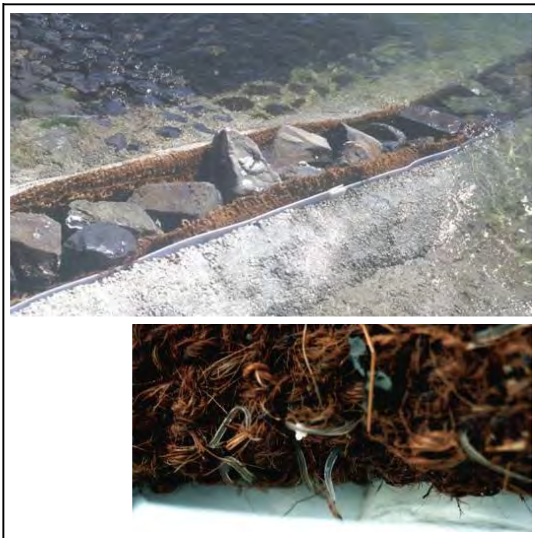
Figura 18.- Vista general i detall d'una rampa específica per a anguiles, situada en un dic de polder dels Països Baixos. Font: Martin Kroes – Visadvis.
