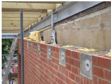
Conservació de la colònia de falciots a un edifici annex a l'estadi de l'Arsenal (Emirates Stadium, Londres). S'observen les cavitats amb el diàmetre necessari.
