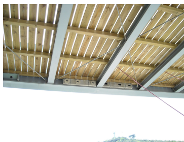
Caixa niu instal·lada sota un pont.
