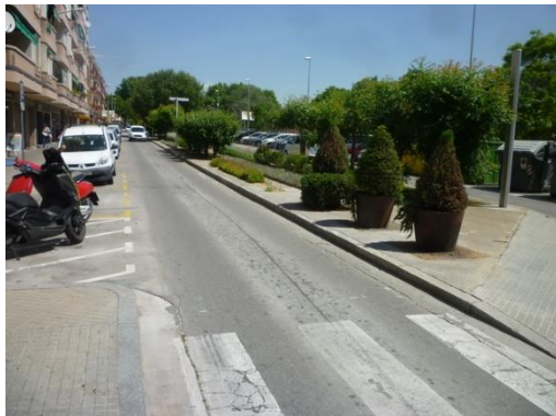
Imatge 3. Exemple de millora de la visibilitat en cruïlla a la rambla de Pompeu Fabra, mitjançant construcció d'orella i instal·lació d'estacionament de motocicleta.
