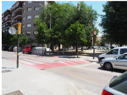
Imatge 4. Exemple d'instal·lació de pas de vianants elevat amb pintura vermella a Vilafranca del Penedès.
