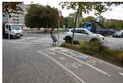
Imatge 52. Carril bici al pont de la font del Rei.
