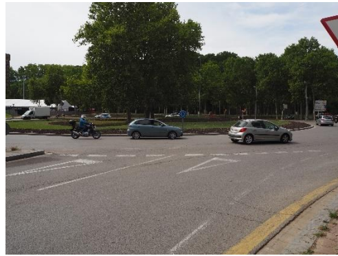
Imatge 68. Rotonda del Pont de Pedret.
