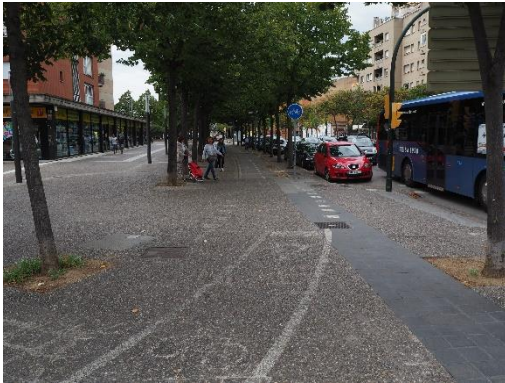
Imatge 25. Manca de visibilitat de la senyalització horitzontal del carril bici al passeig d'Olot.
