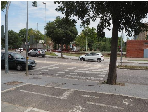
Imatge 79. Encreuament entre carril bici i pas de vianants que pot generar situacions de risc.
