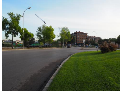
Imatge 109. Accés nord, c. Barcelona. Manca senyalització horitzontal en rotonda.
