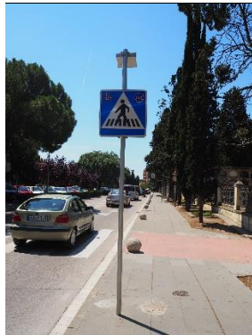
Imatge 5. Exemple d'instal·lació de senyal vertical S-13 de LEDs amb sistema d'autoalimentació amb energia solar a Vilafranca del Penedès.
