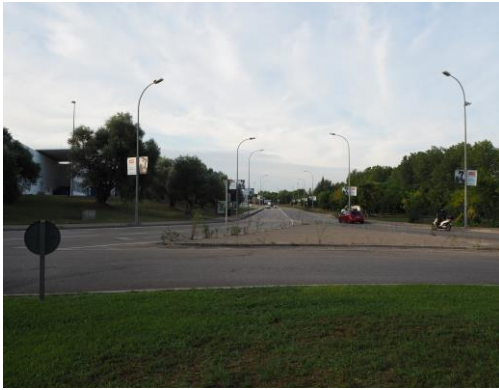
Imatge 108. Accés sud de la intersecció.
