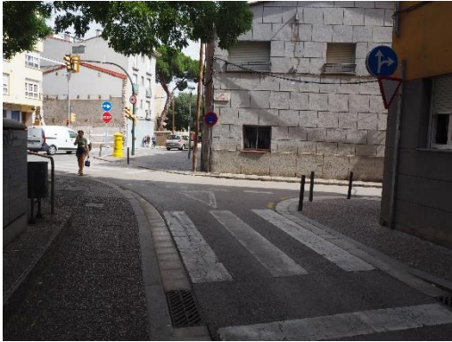
Imatge 15. Carrer de les Guillerries al carrer de Santa Eugènia. Incorporació amb cedeix, senyal d'estop i semàfor, mal estat de la senyalització en calçada.
