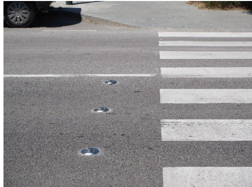
Imatge 6. Sistema d'il·luminació de pas de vianants mitjançant llums LED a Montcada i Reixac.
