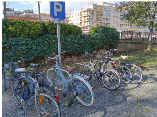
Mòdul de 5 ancoratges tipus U-invertida Carrer del Carme
