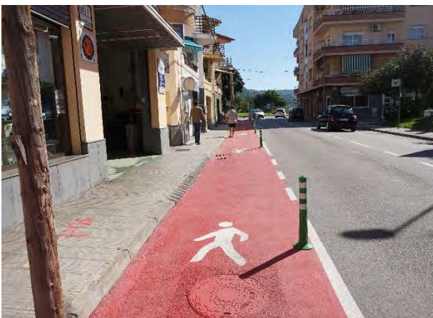
Imatge 17. Exemple d'ampliació de vorera amb pintura i fitons per CE a Olesa de Montserrat (Font: AIM. SL)
