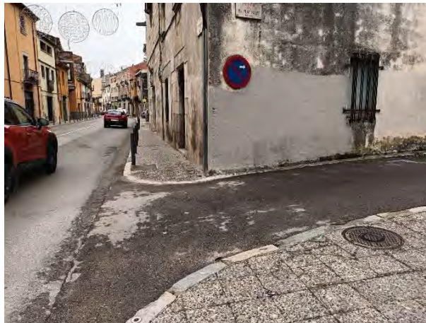
Imatge 8. Creuament carrer del Pont Major amb el passatge Pere Rabat (Font: AIM. SL)
