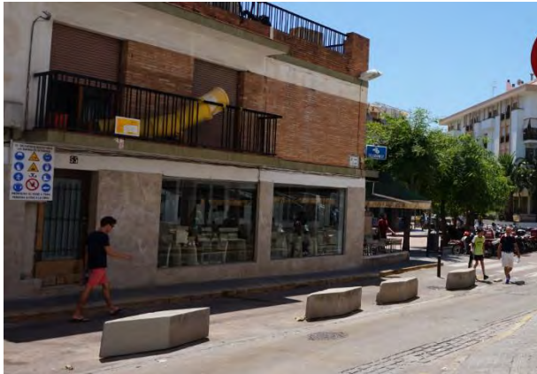
Imatge 19. Exemple d'ampliació de vorera amb blocs de formigó a Sitges (Font: AIM. SL)
