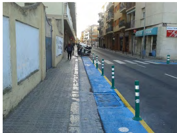
Imatge 18. Exemple d'ampliació de vorera amb pintura i fitons a Vilanova i la Geltrú (Font: AIM. SL)
