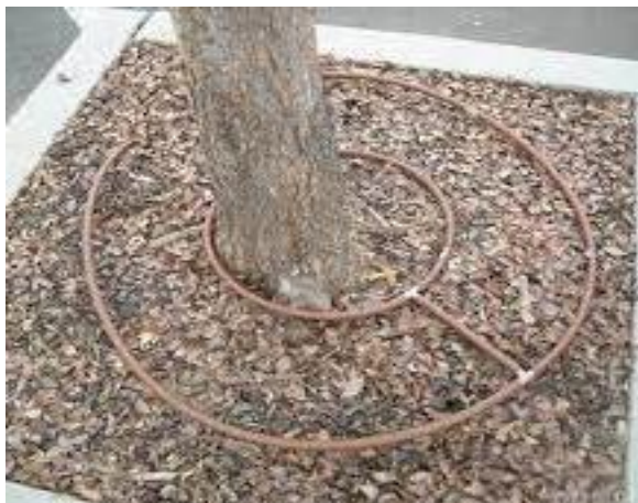
Sistema de doble anell de degoters
