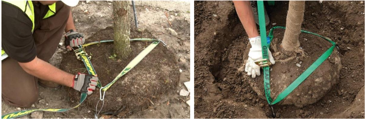
Ancoratges subterranis amb sistema d'eslingues i trinquet.
