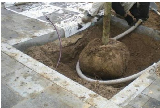
Sistemes d'aireig / irrigació amb tub corrugat de drenatge
