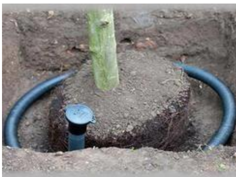
Sistemes d'aireig / irrigació amb tub corrugat de drenatge
