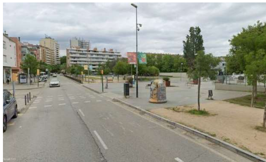
Plaça de Miquel de Palol. Vial que passa per un espai públic molt obert i amb voreres amples; possibilitat de despavimentar parcialment i fer escocells correguts per plantar més arbrat i vegetació.
