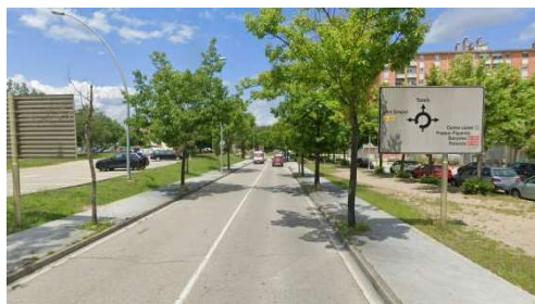
Carretera de Tàlala. Cobertura arbòria que es podria millorar amb uns bons escocells per tal que els arbres creixessin millor i fessin més ombra.
