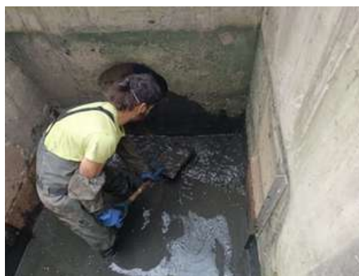
Figura 14. Personal tècnic de la Sorellona i de l'ajuntament de Girona fent el manteniment dels filtres de graves.
