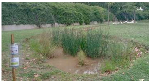
Figura 2. Bassa 1 del Parc Migdia. exemple de bassa amb substrat natural i d'hidroperíode temporani. Esquerra, amb aigua. Dreta, sense aigua. S'asseca a l'estiu de manera natural, i no cal emplenar-la, però és molt important mantenir les rases d'entrada i sortida d'aigua.
