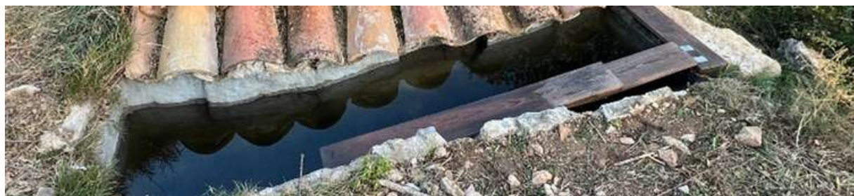
Figura 13. Rampa anti-ofegament de fauna instal·lada a l'abeurador de les Pedreres.
