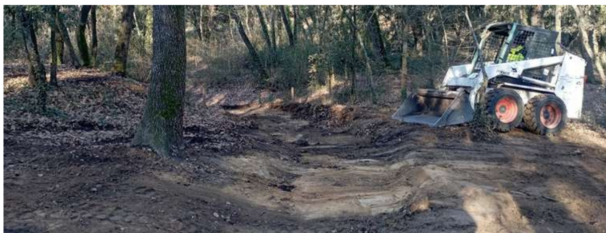
Figura 15. A dalt, rases reperfilades amb aixada. A baix, manteniment de rases amb Bobcat.
