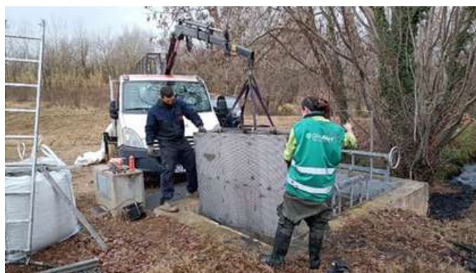
Figura 14. Personal tècnic de la Sorellona i de l'ajuntament de Girona fent el manteniment dels filtres de graves.
