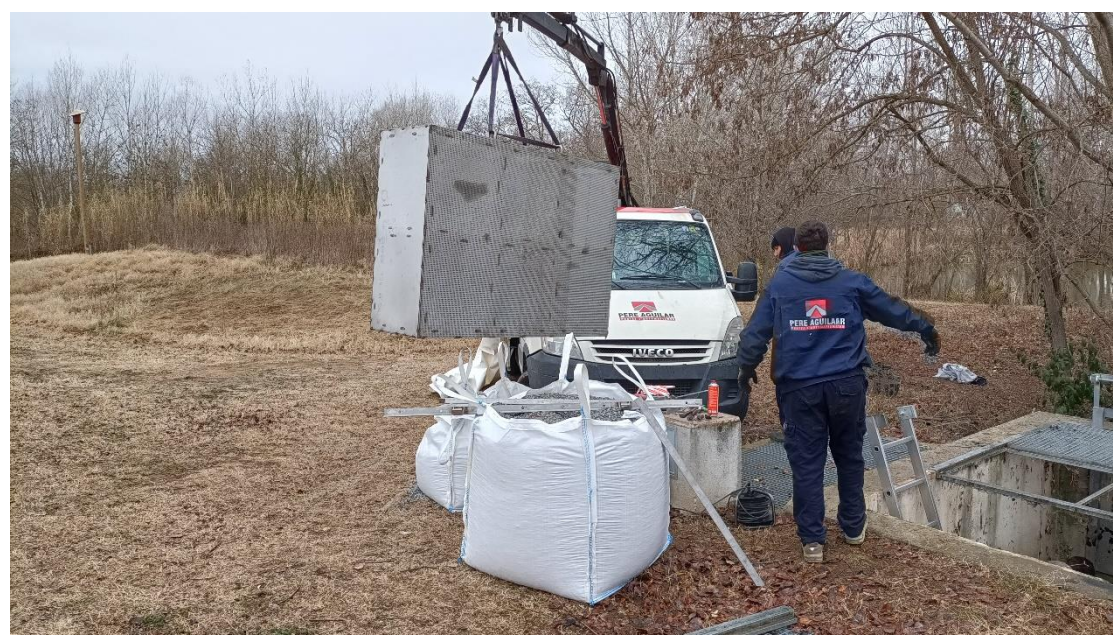
Figura 5. Herreros de la empresa proveedora descargando la estructura del filtro hacia la arqueta.
