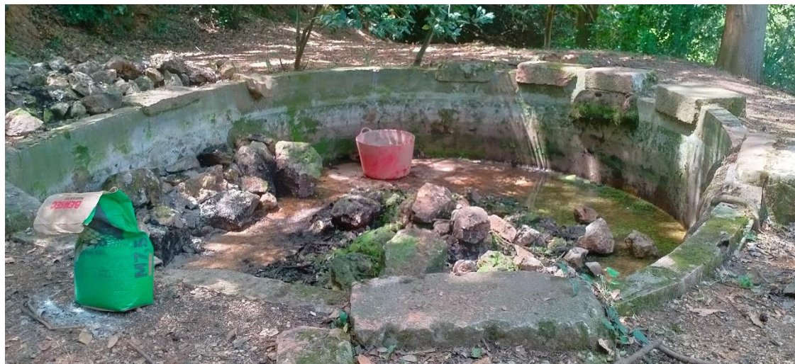
Figura 6: Inicio de la rampa anti-ahogo con mortero y bloques y piedras naturales.
