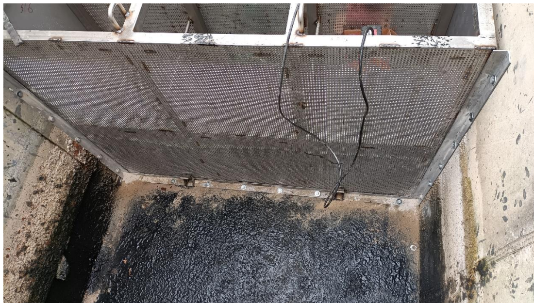
Figura 7. Estructura metálica instalada y guías para fijar la estructura a la arqueta.
