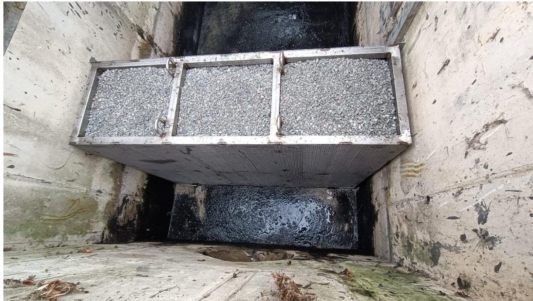
Figura 9. Filtro de gravas instalado.
