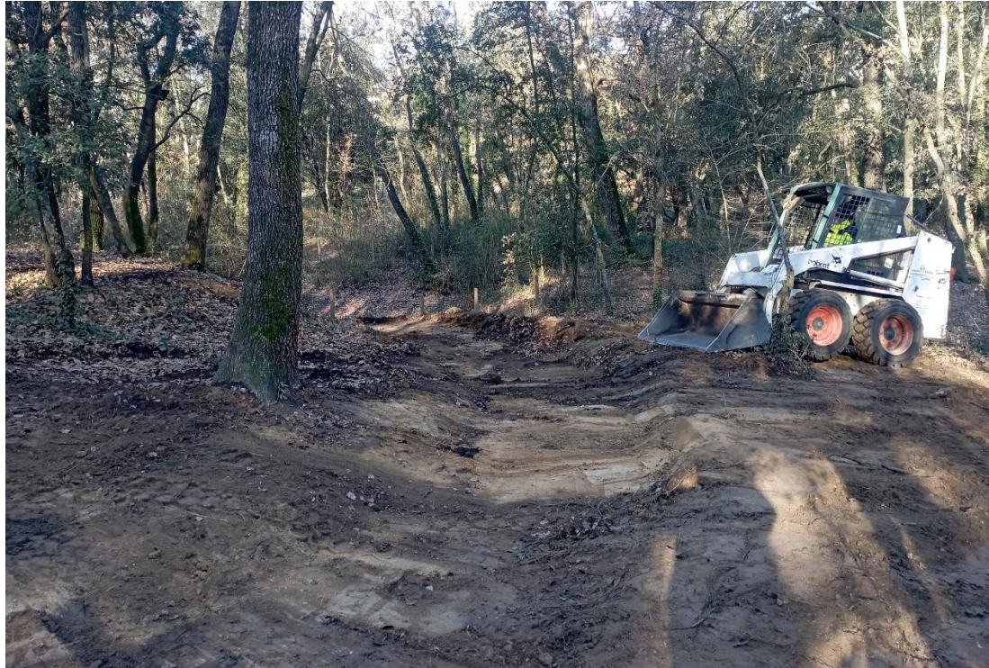
Figura 3. Bobcat excavando la nueva zanja de captación del agua de escorrentía. Foto del 5/03/2024
