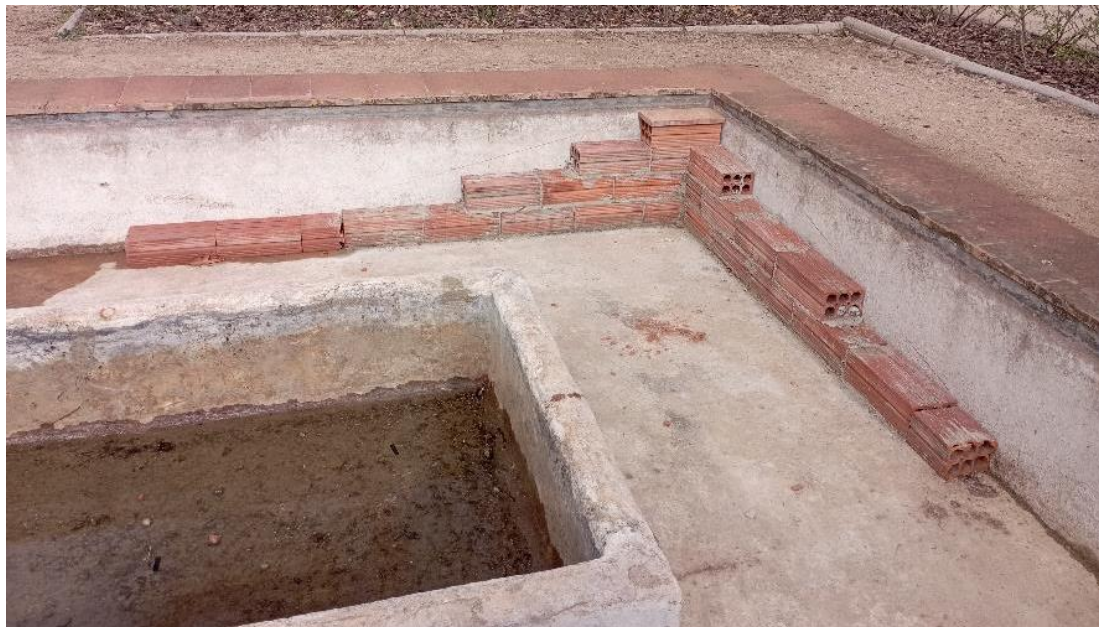
Figura 2. Inicio de la construcción de las rampas anti-ahogamiento de fauna.
