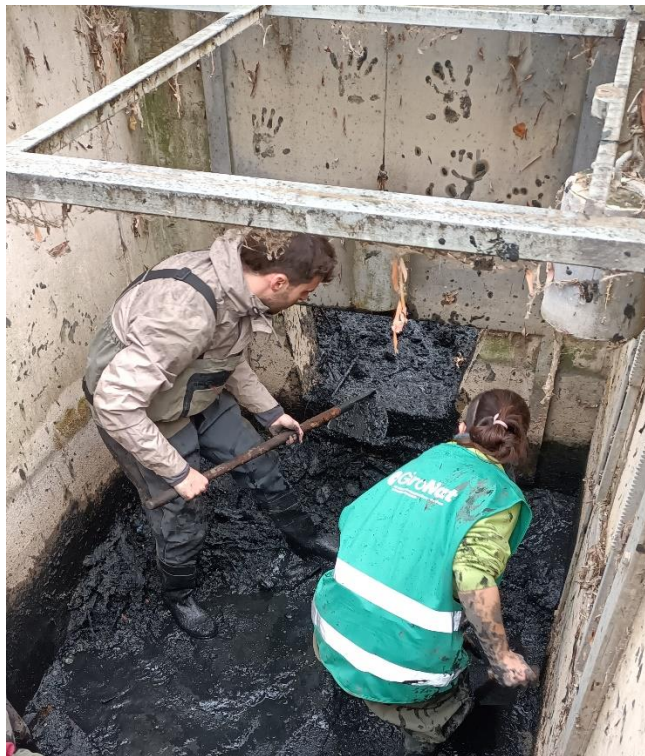
Figura 3. Técnicos de la Sorellona extrayendo el lodo de la arqueta.
