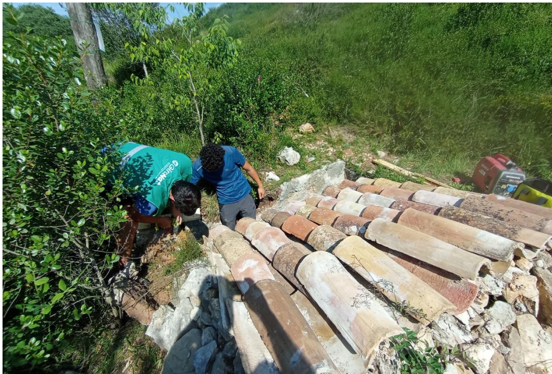
Figura 6: Técnicos de La Sorellona instalando la rampa.
