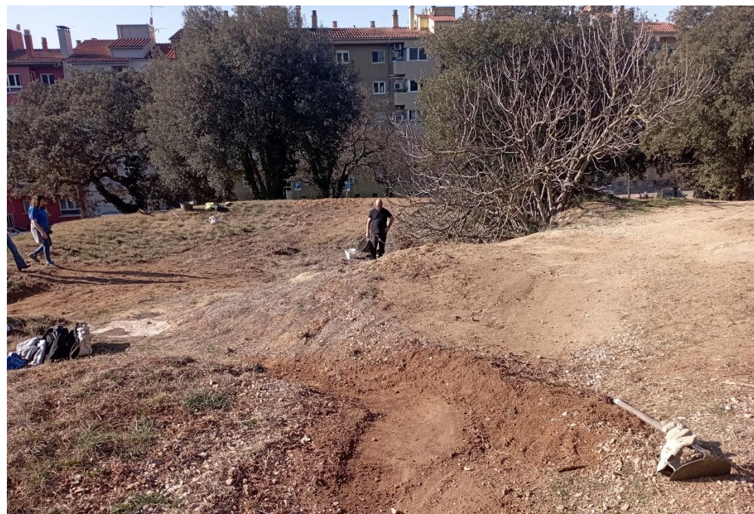
Figura 6: Pequeña zanja de derivación de agua hacia la charca, excavada a mano en el marco de la jornada de voluntariado del día 19 de febrero de 2024.
