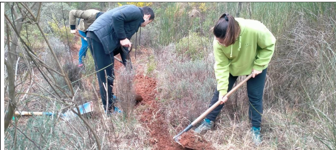
Figura 8. Creación de la zona 1 de canales de escorrentía.
