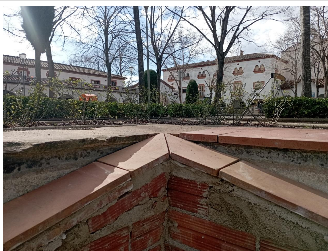
Figura 3. Una de las dos rampas acabadas.
