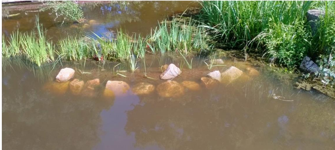
Figura 30: Biorrollo colocado con la sujeción de las piedras, que a su vez servirán para refugios de fauna acuática.
