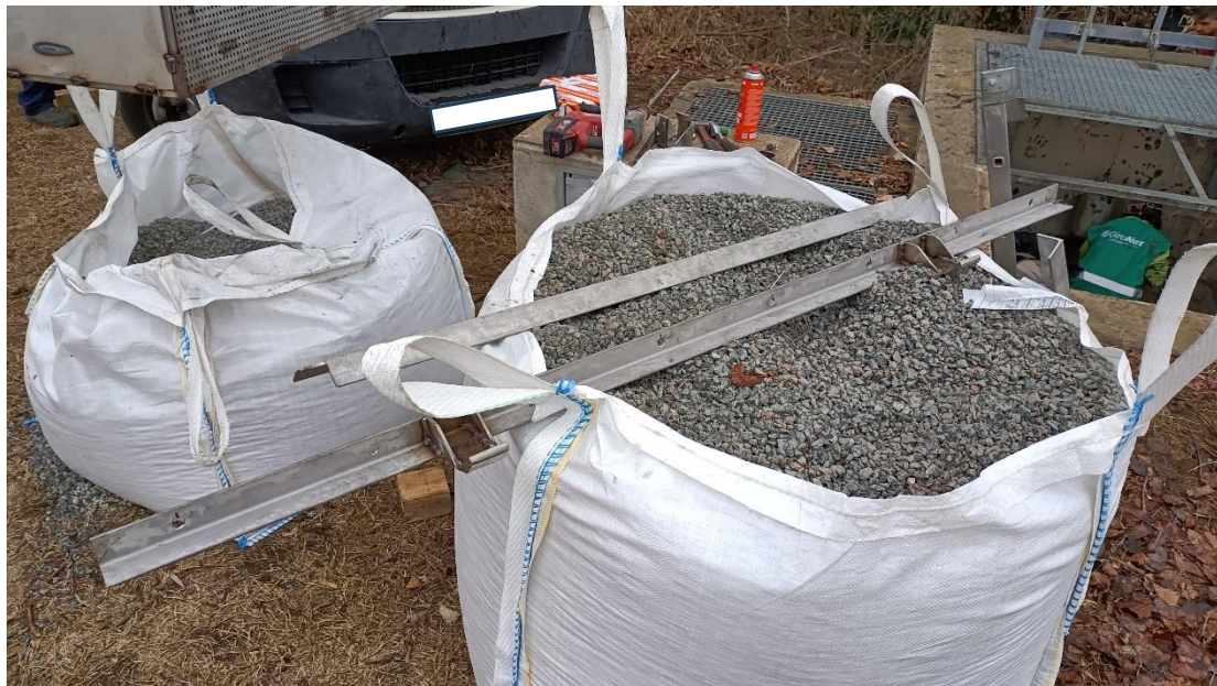
Figura 6. Big bags de grava utilizada para rellenar la estructura metálica.
