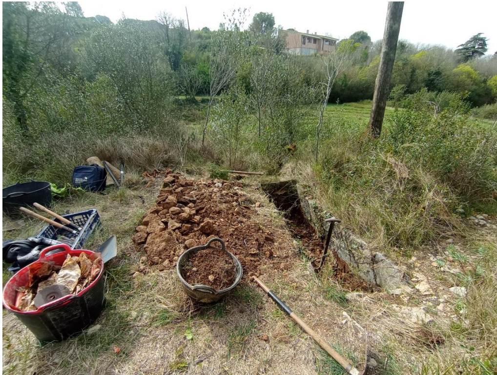
Figura 3: Trabajos de extracción de la vegetación, piedras y tierra del interior del abrevadero.
