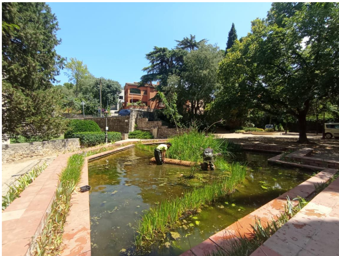
Figura 8: Colocación de los biorrollos de fibra de coco dentro de la charca.
