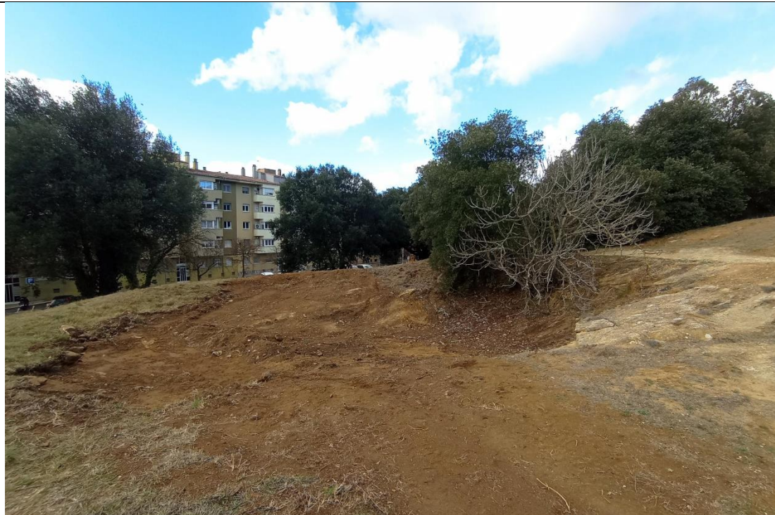
Figura 7: Después del voluntariado se ha acabado de extraer tierra con maquinaria para profundizar la cubeta y reperfil los márgenes.
