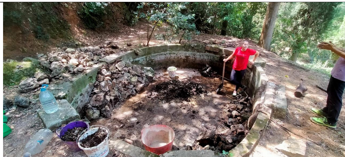
Figura 7: Construcción de la rampa y extracción de materia orgánica.
