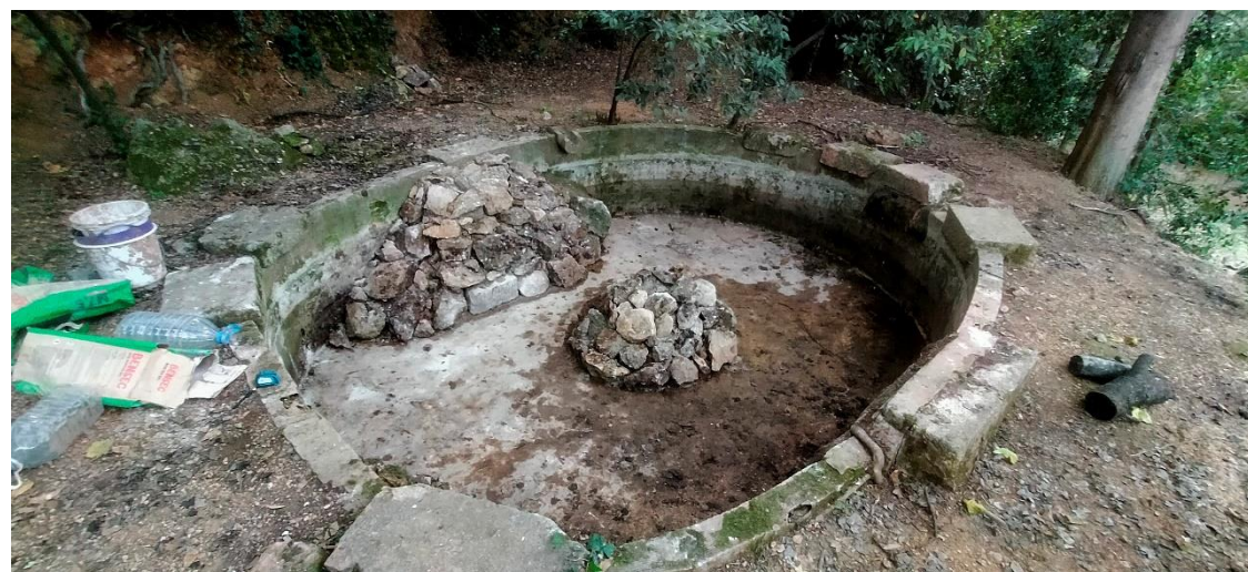
Figura 9: Presentación final de la rampa anti-ahogamiento y el refugio central.
