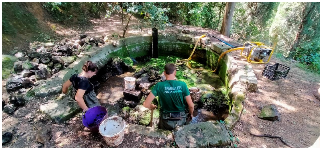
Figura 3: Después del vaciado se procede a la limpieza de materia orgánica.
