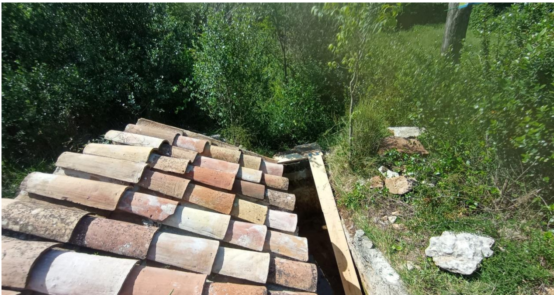
Figura 9: Rampa para evitar ahogamientos de fauna.
