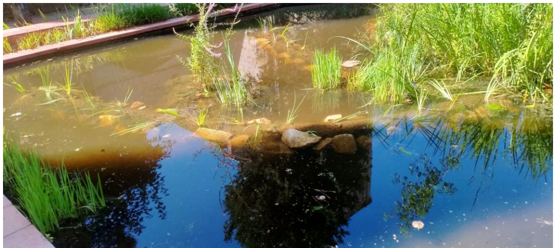
Figura 41: Biorrollo de fibra de coco sujeto con los bloques y piedras que servirán tanto como fijación del biorrollo como para refugios de fauna acuática.
