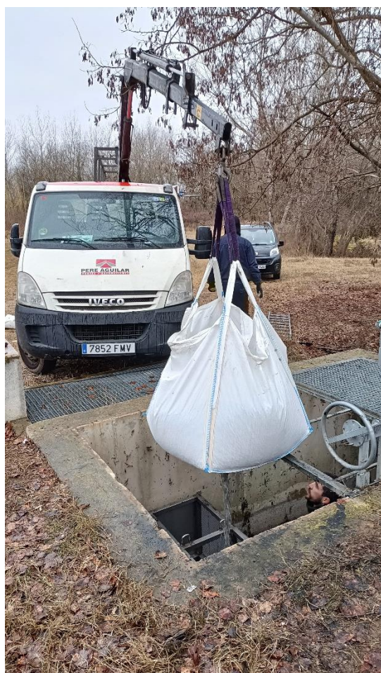
Figura 8. Rellenando el filtro de gravas.
