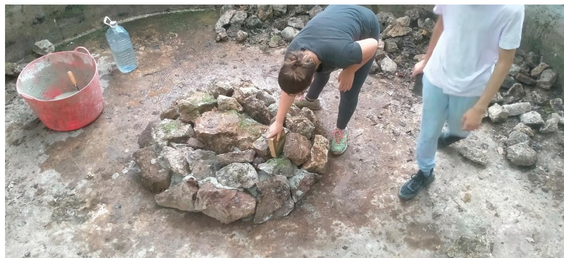
Figura 8: Construcción del refugio de fauna acuática central con mortero.
