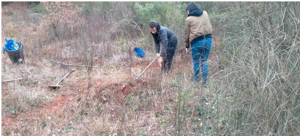
Figura 7. Reconducción de la zona 1 del canal de escorrentía.
