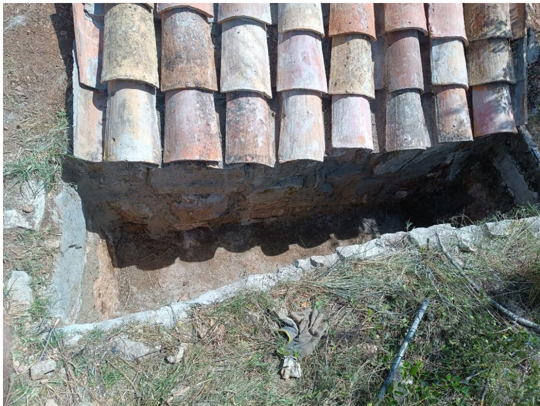
Figura 7: Abrevadero impermeabilizado
