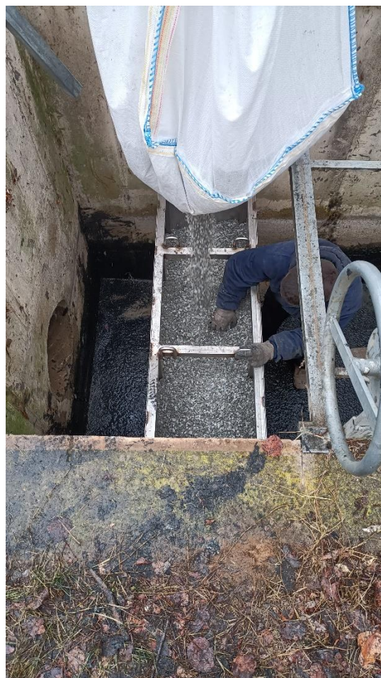
Figura 7. Estructura metálica instalada y guías para fijar la estructura a la arqueta.
