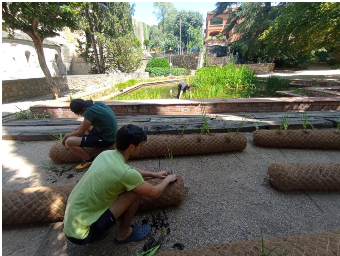
Figura 6: Técnicos de la Sorellona plantando helófitas, en este caso lirios amarillos ( Iris pseudacorus ), en los biorrollos de fibra de coco.
