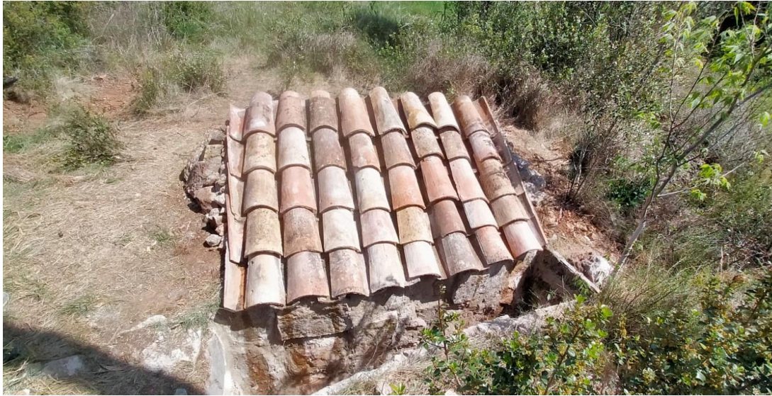
Figura 6: Tejas instaladas sobre el refugio para canalizar el agua de lluvia hacia el abrevadero.
