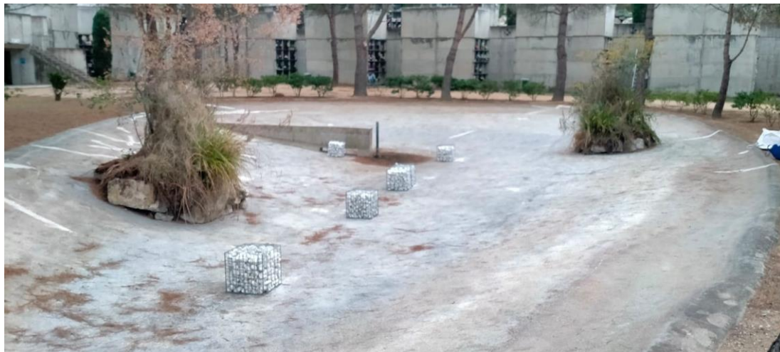
Figura 5: Refugios hechos con gabiones de piedra instalados en la charca del Cementiri Nou de Girona.
