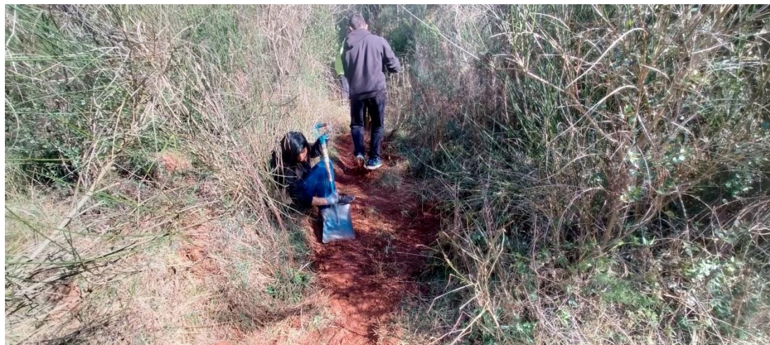
Figura 10. Reconducción del canal de escorrentía de la zona 3.
