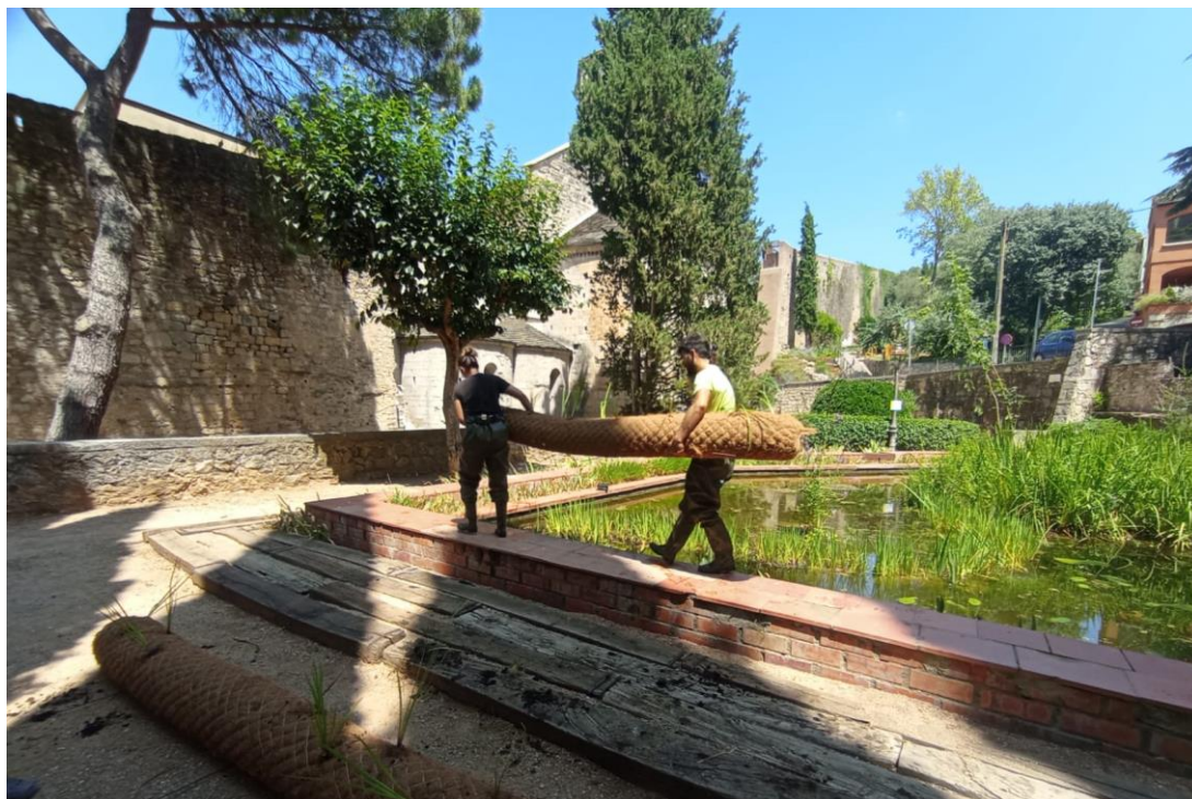
Figura 7: Colocación de biorrollos con lirios amarillos plantados dentro de la charca.
