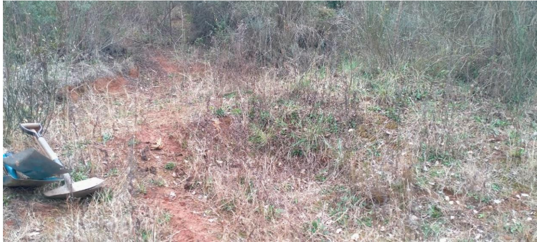
Figura 3: Canal de escorrentía de la zona 1. Parte próxima a la charca. Día 28/02/2024.
