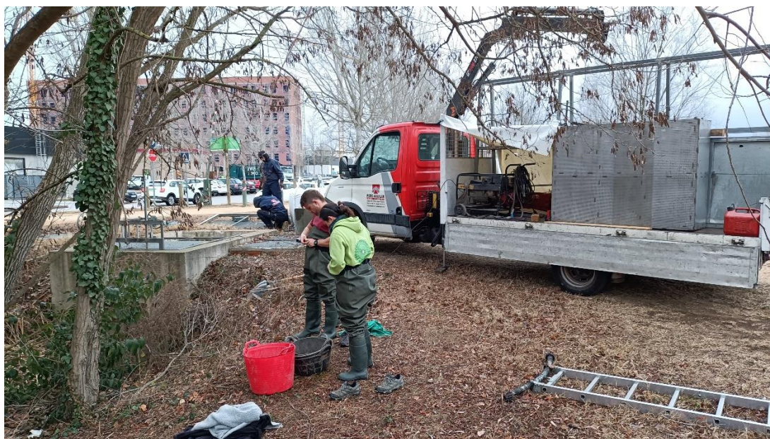
Figura 4. Camión transportando la estructura del filtro hacia la arqueta.
