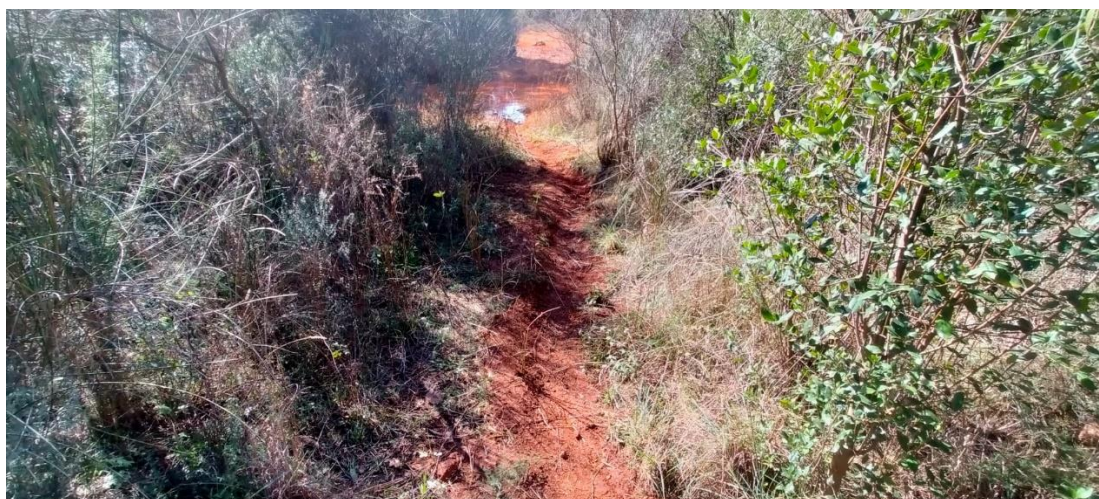
Figura 13. Canal de escorrentía reconducido de la zona 3.
