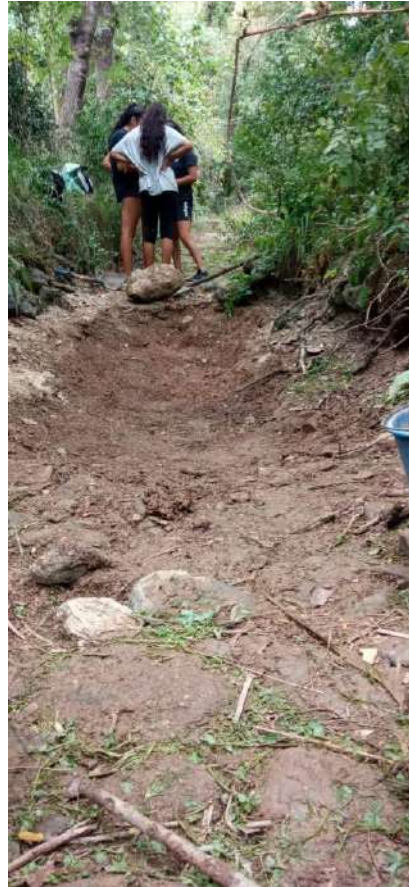
Figura 2: Poza después de la actuación.
