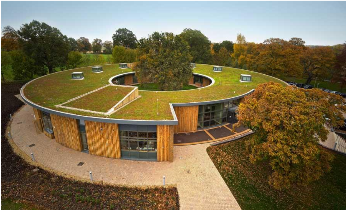
Figura 4. Coberta verda a la seu de la British Horse Society a Kenilworth, formada principalment per crespínells. Autor: Sky Garden Ltd (CC BY-SA 4.0).
