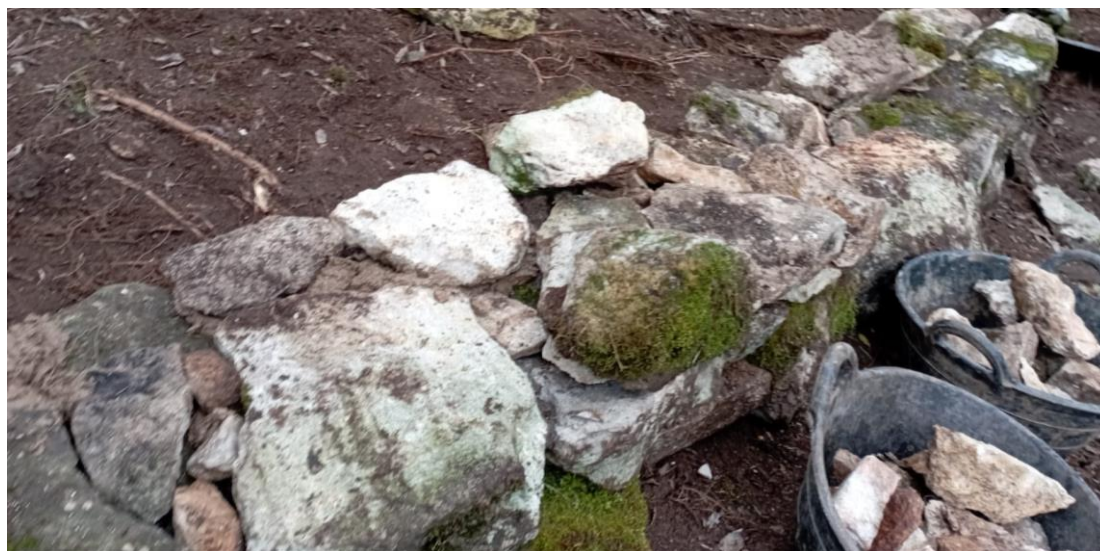
Figura 9. Detalle del muro y las piedras usadas.
