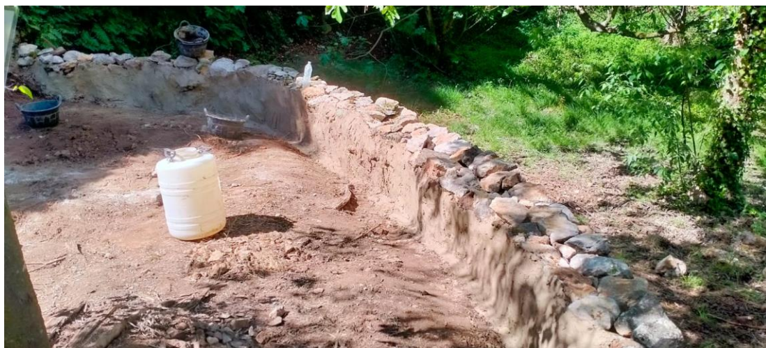
Figura 13. En esta imagen se aprecia el muro totalmente cubierto con mortero de cal por su parte interior.
