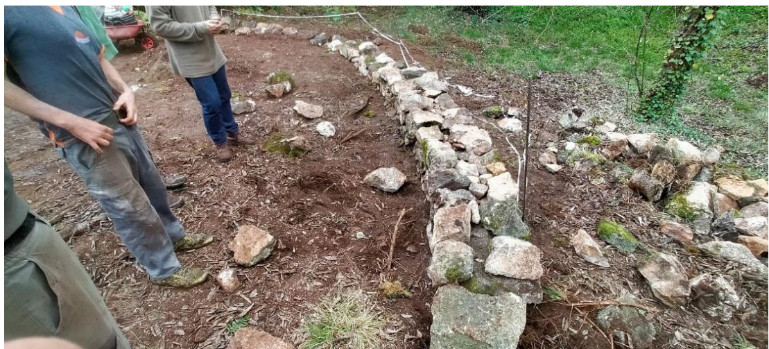
Figura 7. Una vez hecha la base, se empieza a subir el muro. Se ha marcado la altura del muro con cuerdas y varillas.
