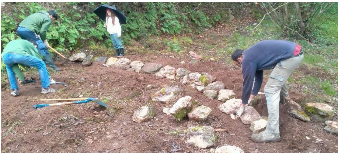
Figura 6. Marcando la primera línea de piedras que confeccionará la base del muro.
