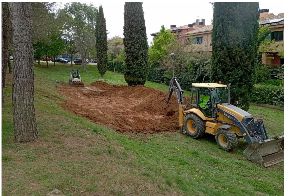
Figura 8. Visita de campo de técnicos de La Sorellona en el momento de la excavación de la charca 1 del Parc de Puigvistós, explicando detalles a técnicos del ayuntamiento de Girona para la correcta ejecución de la acción.
