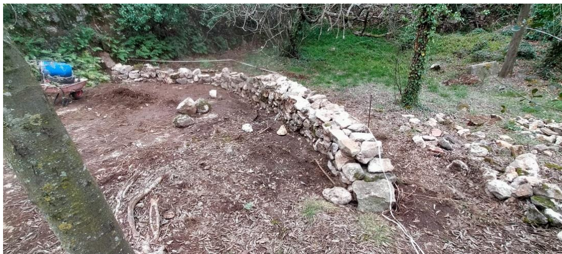
Figura 11. Muro en construcción, día 27 de marzo de 2024.
