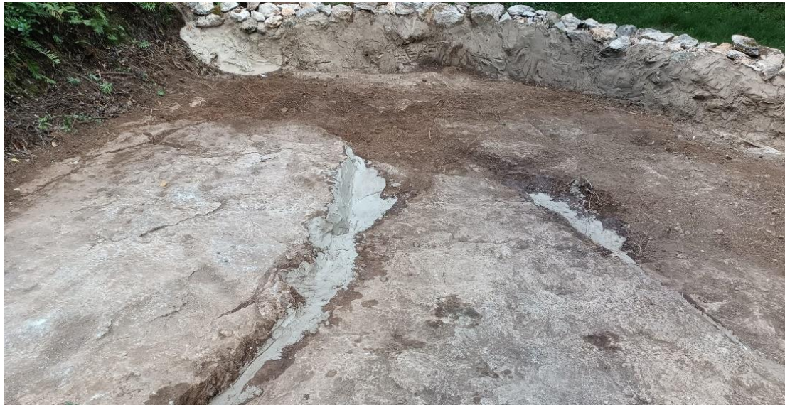
Figura 14. Impermeabilizando las gretas con mortero de cal.
