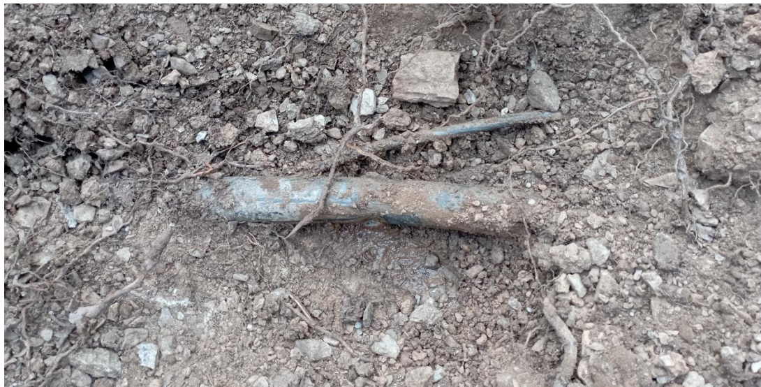
Figura 6. Durante la excavación de la charca se encontró un tubo antiguo de plomo, la cual cosa obligó a cambiar de rumbo, tapar la pequeña charca construida y ensanchar más la zanja para que se acumulara ahí el agua y conseguir el microhábitat acuático deseado.
