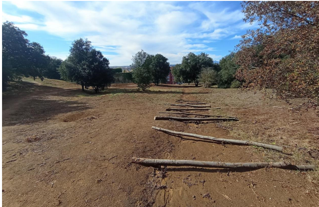
Figura 6. Una de las zanjas de canalización de agua de lluvia que recoge agua de un camino, donde se ve que ha funcionado y que deriva mucha agua hacia la charca.
