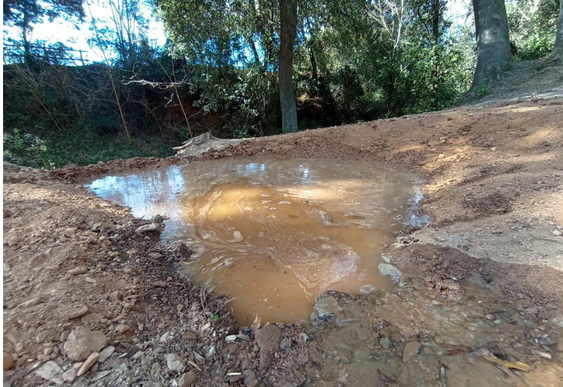
Figura 7. Para conseguir el objetivo de crear un nuevo hábitat acuático se amplió la zanja hasta conseguir una superficie de 6,66 m 2 . Se llenó con agua de la fuente para valorar su permeabilidad.
