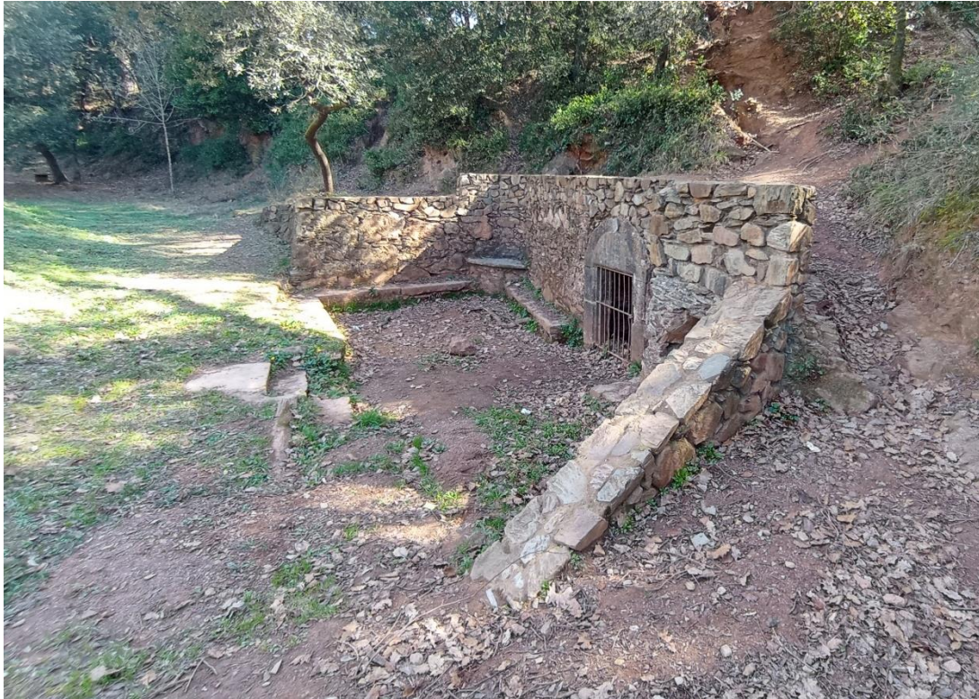
Figura 3. Estado inicial del lugar. En el centro de la fotografía se aprecia una antigua estructura rectangular de piedra, colmatada completamente por sedimentos. A la derecha se observa el camino con fuerte pendiente, que alimentará con agua la futura charca.
