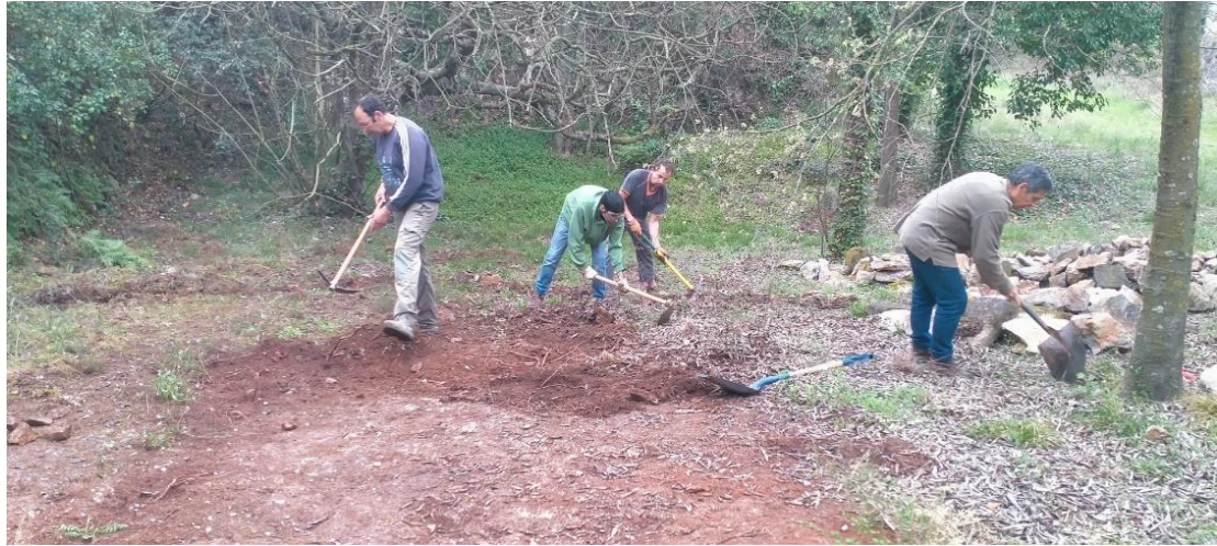
Figura 5. Inicio de la construcción del muro de contención del agua, el día 25 de marzo de 2024, donde colaboran técnicos de La Sorellona, Xavier Laporta, experto en muros de piedra y voluntarios de la entidad.
