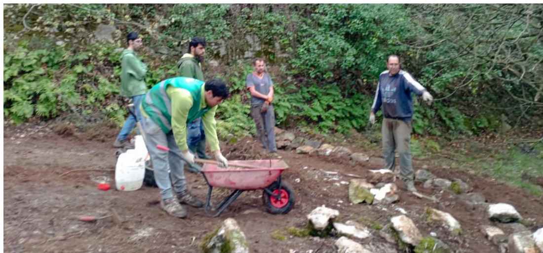
Figura 8. Técnico de La Sorellona haciendo el mortero de cal, según indicaciones de Xavier Laporta, experto en construcción con piedra natural.
