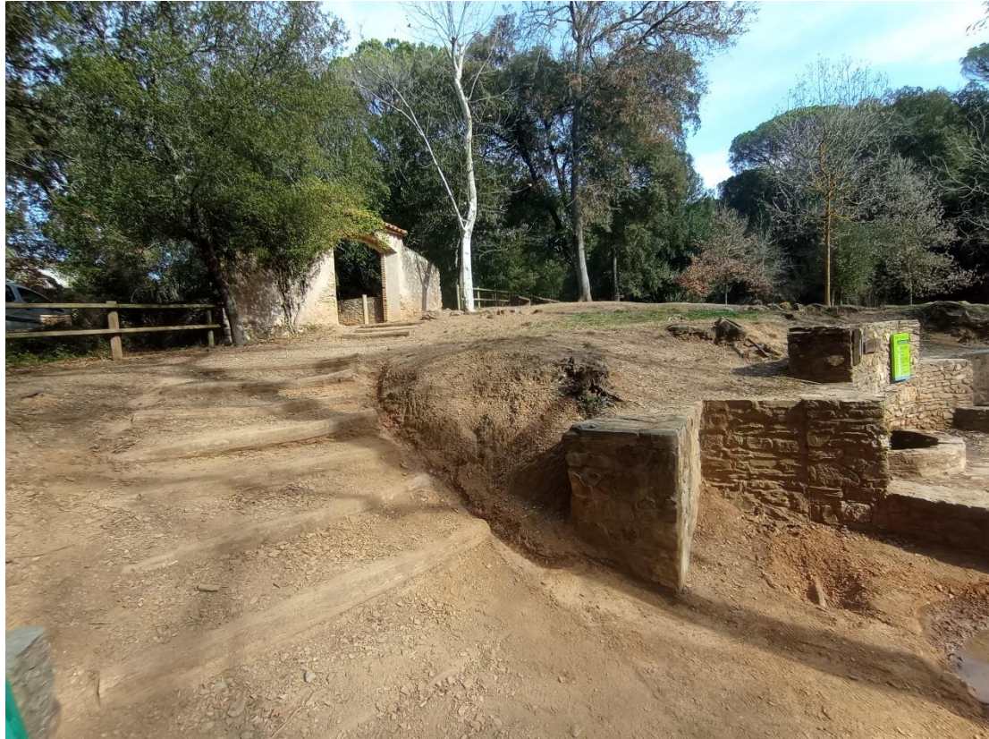
Figura 5. Pequeña zanja excavada al lado de las escaleras en el centro de la fotografía. A la derecha se ve el agua de la pequeña charca excavada, y el tubo destapado de la fotografía de abajo, lo cual hizo repensar la actuación y ensanchar más de lo previsto la zanja de evacuación del agua sobrante de la fuente.
