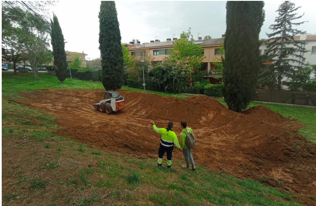
Figura 7. Visita de campo de técnicos de La Sorellona en el momento de la excavación de la charca 1 del Parc de Puigvistós, explicando detalles a técnicos del ayuntamiento de Girona para la correcta ejecución de la acción.
