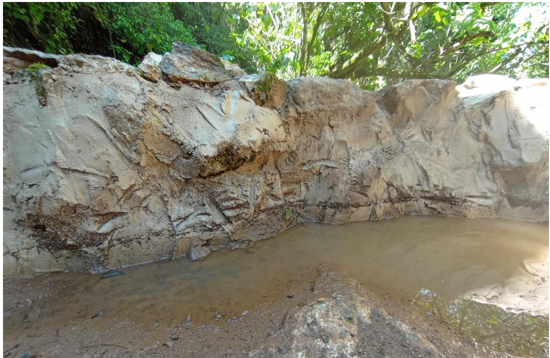
Figura 17. Agua acumulada a día 3 de mayo de 2024, cuando todavía está pendiente acabar la zanja de recogida de agua del camino.
